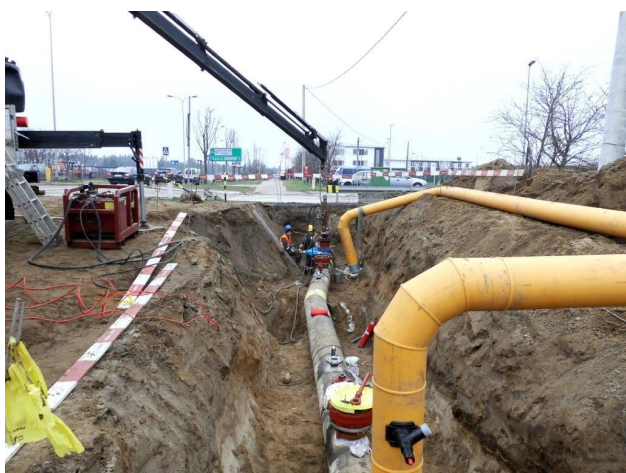
Budowa Pomorskiej Kolei Metropolitalnej - przebudowa gaziociągu zasilającego Gdańsk bez zatrzymania przepływu
