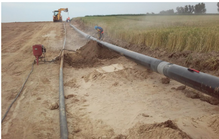
Przebudowa gazociągu wc dn 150 - na zadaniu udowa drogi ekspresowej S-5 Szubin-Jaroszewo
