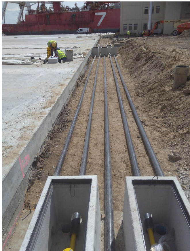
Budowa gazociągów technologicznych na terenie Stoczni Gdańskiej - Wyspa Ostrów
