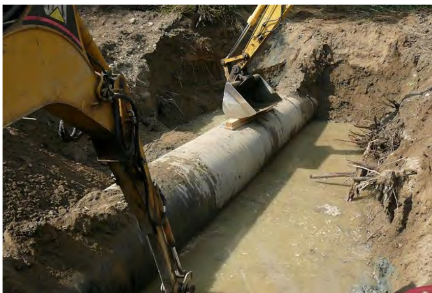
Zdj. 2. Ponowne posadowienie kolektora PE DN1400 w Nowym Sączu po ustąpieniu powodzi (fot. Kazimierz Kudlik)
